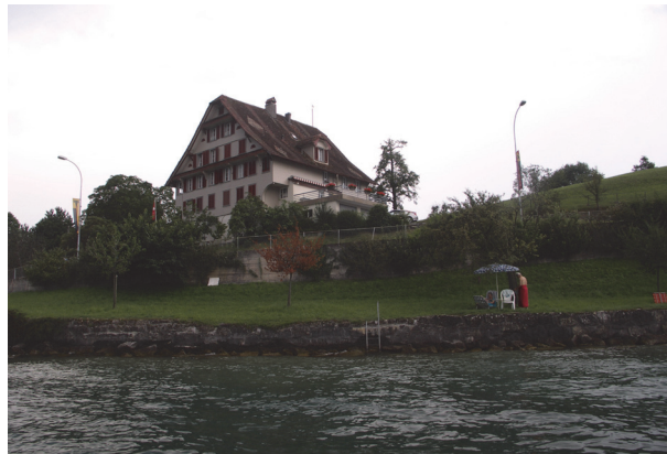
Ufersituation im Bereich von Transekt 5252. Kanton LU, VitznB, 2008. Projekt: «AKV Profile LU». Startpunkt: 673'411 / 208'411. Azimut: 141°.
