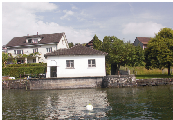
Ufersituation im Bereich von Transekt 28112. Kanton LU, HorwS, 2009. Projekt: «AKV Profile LU». Startpunkt: 667'875 / 205'875. Azimut: 136°.
