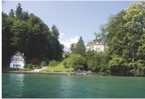
Ufersituation im Bereich von Transekt 28644. Kanton LU, HorwS, 2009. Projekt: «AKV Profile LU». Startpunkt: 668'602 / 207'602. Azimut: 81°.
