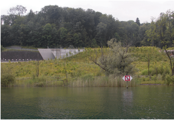
Ufersituation im Bereich von Transekt 27282. Kanton LU, HorwS, 2009. Projekt: «AKV Profile LU». Startpunkt: 666'203 / 206'203. Azimut: 56°.
