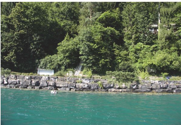
Ufersituation im Bereich von Transekt 6214. Kanton LU, VitznB, 2008. Projekt: «AKV Profile LU». Startpunkt: 676'982 / 208'982. Azimut: 209°.
