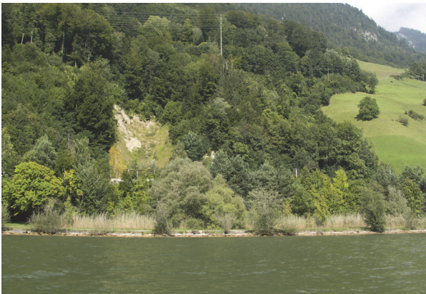
Ufersituation im Bereich von Transekt 25263. Kanton OW, AlpnS, 2008. Projekt: «AKV Profile OW». Startpunkt: 664'194 / 201'194. Azimut: 138°.
