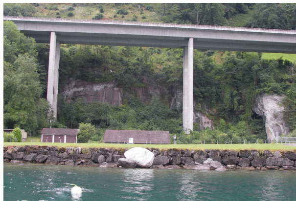
Ufersituation im Bereich von Transekt 17833. Kanton NW, GersB, 2009. Projekt: «AKV Profile NW». Startpunkt: 681'374 / 201'374. Azimut: 348°.
