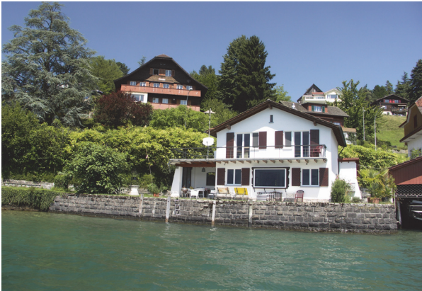
Ufersituation im Bereich von Transekt 5442. Kanton LU, VitznB, 2008. Projekt: «AKV Profile LU». Startpunkt: 674'113 / 209'113. Azimut: 182°.
