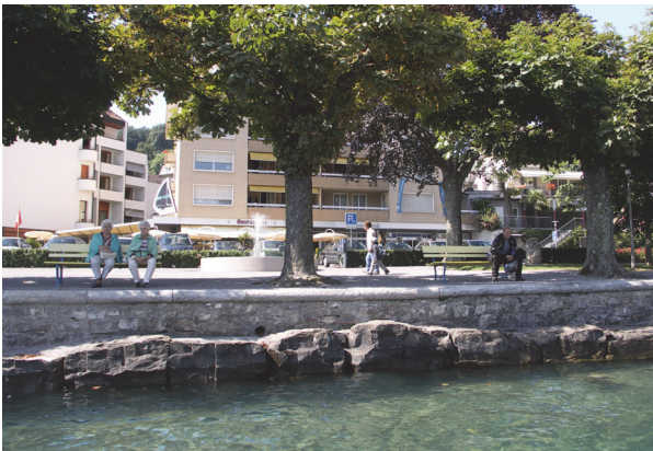
Ufersituation im Bereich von Transekt 5842. Kanton LU, VitznB, 2008. Projekt: «AKV Profile LU». Startpunkt: 675'649 / 209'649. Azimut: 146°.
