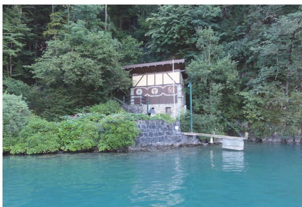
Ufersituation im Bereich von Transekt 11323. Kanton UR, UrnS, 2010. Projekt: «AKV Profile UR». Startpunkt: 689'970 / 200'970. Azimut: 260°.
