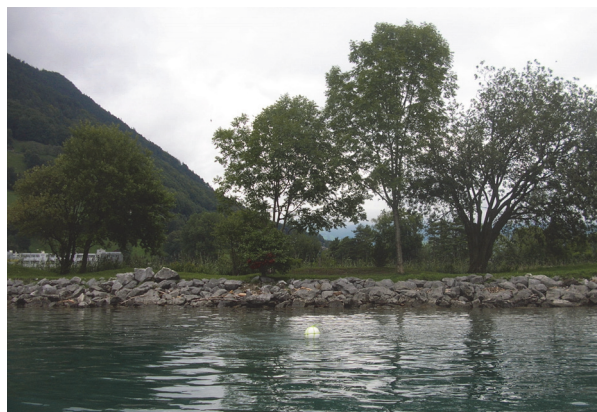
Ufersituation im Bereich von Transekt 9765. Kanton SZ, GersB, 2007. Projekt: «AKV HS Hopfräben». Startpunkt: 687'647 / 205'647. Azimut: 228°.
