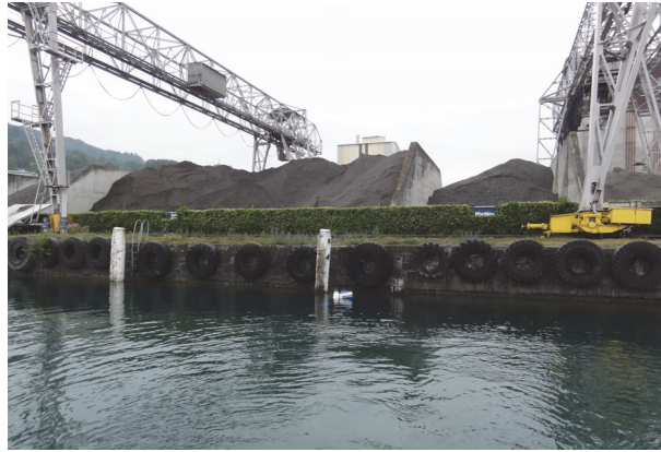
Ufersituation im Bereich von Transekt 27464. Kanton LU, HorwS, 2011. Projekt: «AKV Profile LU». Startpunkt: 666'115 / 206'115. Azimut: 300°.
